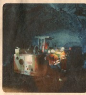
Attività in sotterraneo per lo scavo della galleria esplorativa, realizzata dalla ditta specializzata Edilmac
